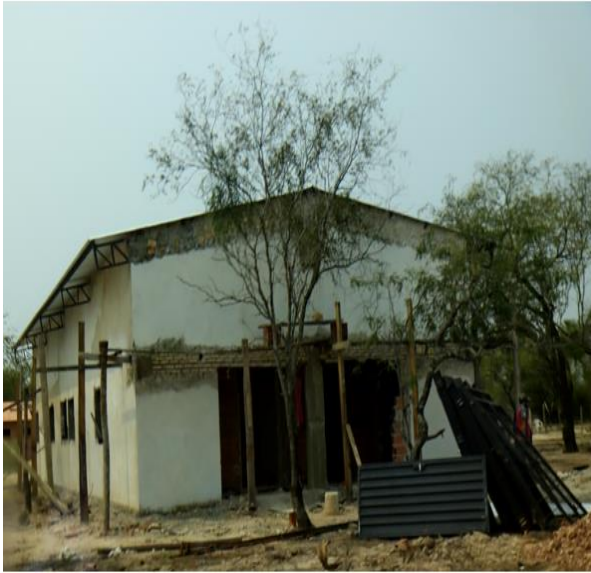
Obras de construcción de un centro comunitario para la Comunidad indígena Yakye Axa, tal como se observaron durante la visita de 2024.
