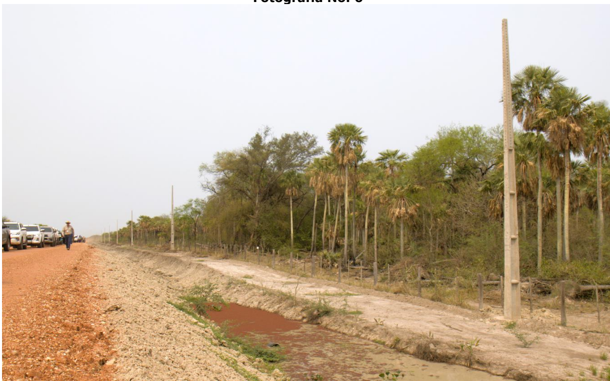
Verificación de las cunetas y postes para la instalación del tendido eléctrico en el camino de acceso a las tierras alternativas de la Comunidad indígena Yakye Axa.
