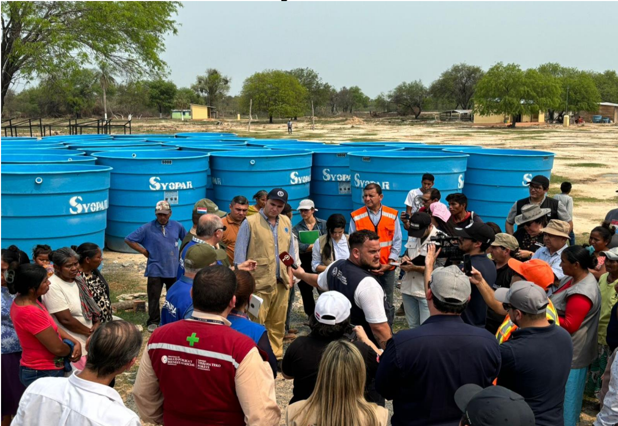
Verificaciones realizadas durante la visita respecto al sistema de captación y almacenamiento de agua para la Comunidad indígena Yakye Axa. En la imagen se pueden apreciar los tanques de fibra de vidrio.
