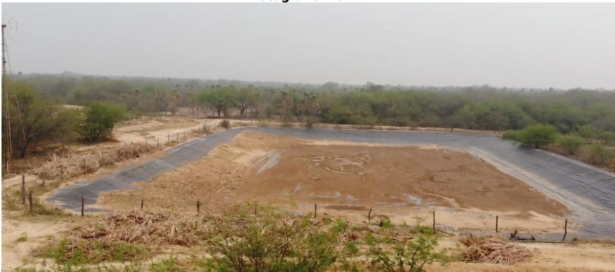
*Tajamar construido por el Estado en beneficio de la Comunidad indígena Xákmok Kásek. En la imagen, se puede apreciar que el tajamar es de grandes dimensiones, con piso recubierto de geomembrana sintética y perímetro cercado, y un molino de viento.*
