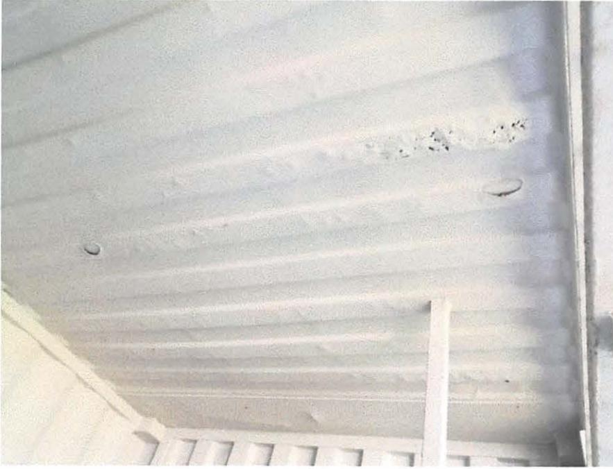
Se observa en el área de las celdas signos de oxidación en la parte superior del contenedor.
