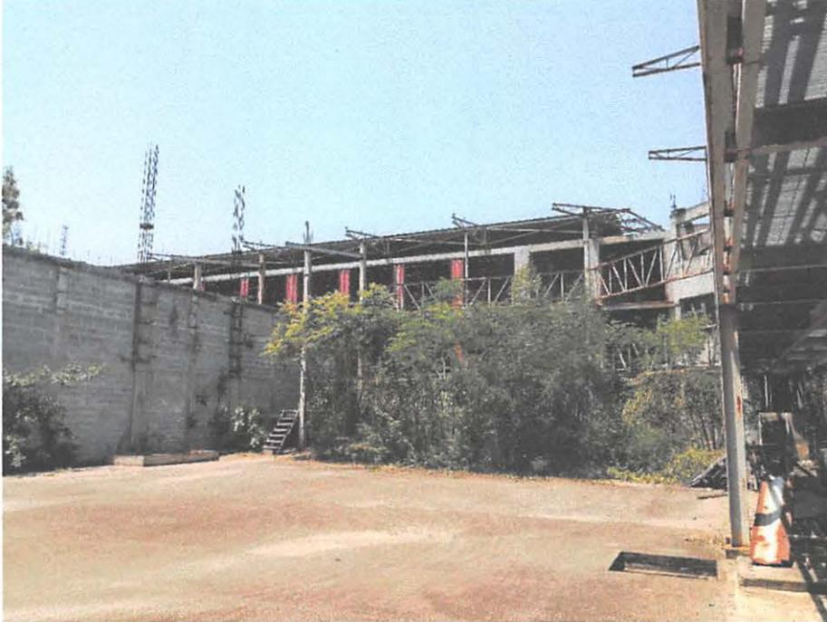
Se observa la construcción de la estructura del techo de la pasarela y signos de oxidación de los elementos de acero – estructura del techo, pasarela, acero de refuerzo de columna de amarre de muro central.
