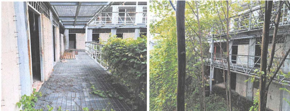
En cuanto a los materiales de construcción de los Módulos como los contenedores principalmente presentan deterioro estructural, especialmente en las paredes entre celdas y paredes posteriores, pudiendo los PL, provocar con facilidad daños, incurriendo deficiencias de seguridad y necesidad mantenimiento por la fragilidad de la estructura construida, así mismo los ventanales superiores deben ser cerrados ya que esto facilitado el acceso a los pasillos.
