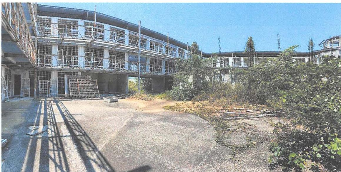
Se observa estructura de acero en general con signo de oxidación y la construcción de losa de piso del patio central y cajas pluviales.
