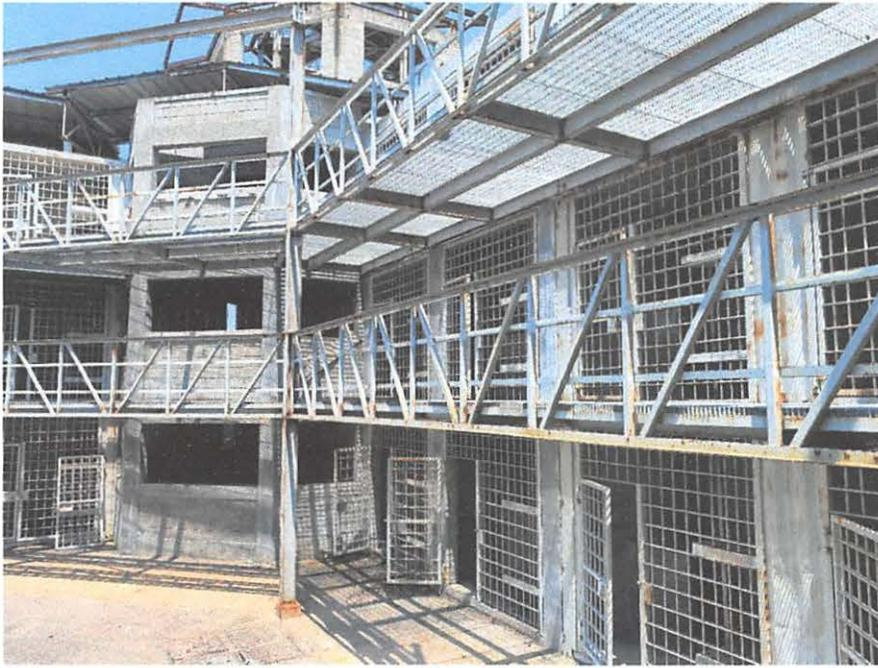
Se observa signos de oxidación en los elementos de acero –estructura de la pasarela, barandales, y rejas de las celdas.
