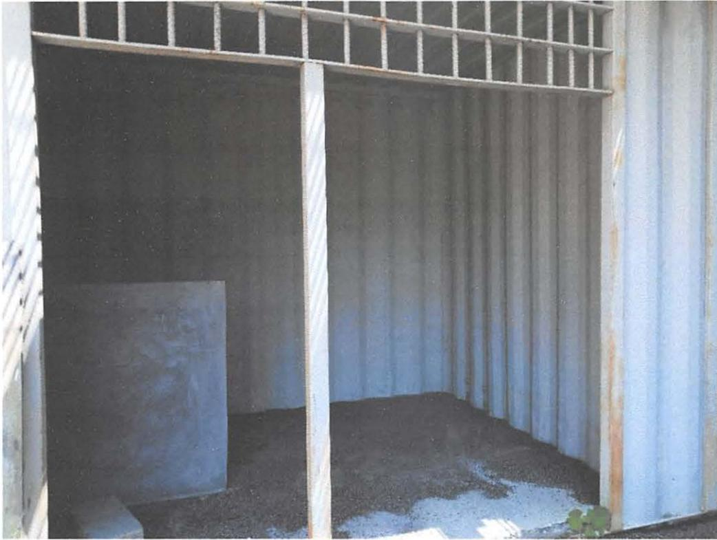
Se observa en las celdas que no se ha construido las losas de concreto para las camas y en otros casos que no se terminado de construir y el acero está expuesto con signos de oxidación.
