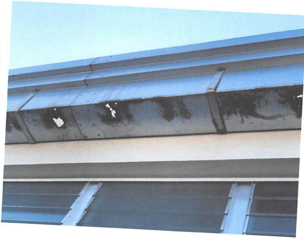
Canal con grado de deterioro avanzado que ha causado la corrosión de la lámina de acero.
