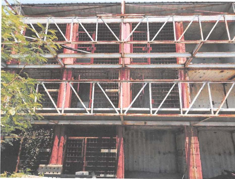
Se observa elementos de acero con signos de oxidación – estructura de soporte de pasarela, barandales, rejas de celdas, estructura de techo, paredes de celdas (contenedor)
