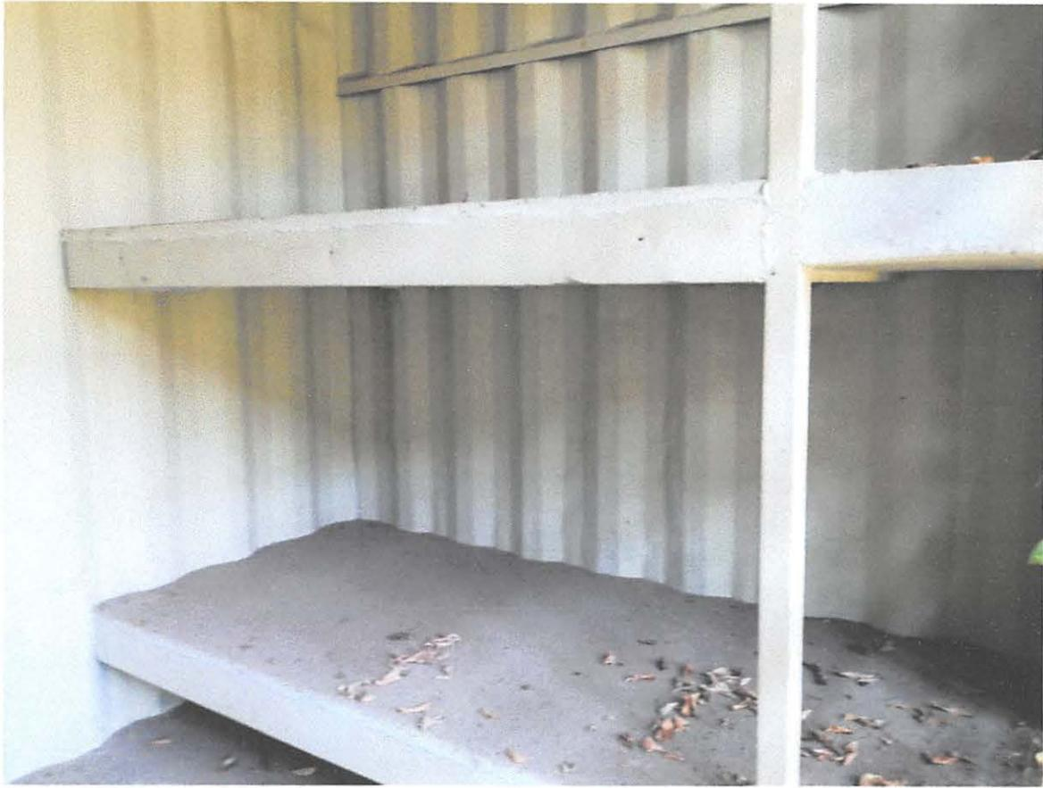
Se observa en el área de las celdas construcción de losa de concreto para la cama e instalación de tuberías para el área de sanitario.
