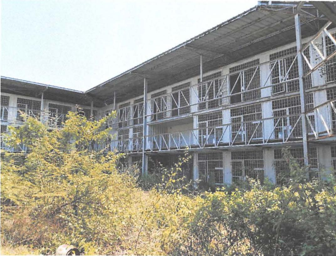
Se observa elementos de acero con signos de oxidación – estructura soporte de la pasarela, barandales, rejas de celdas y estructura de techo.
