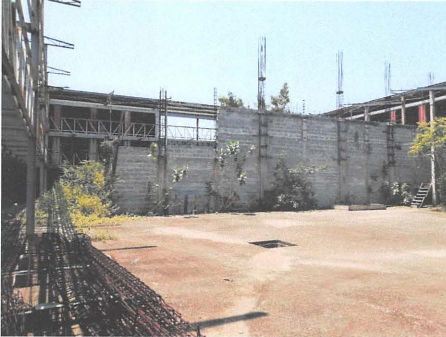
Se observa la construcción del muro central de bloques de hormigón y acero que divide al módulo – acero de refuerzo expuesto que evidencia signos de oxidación.
