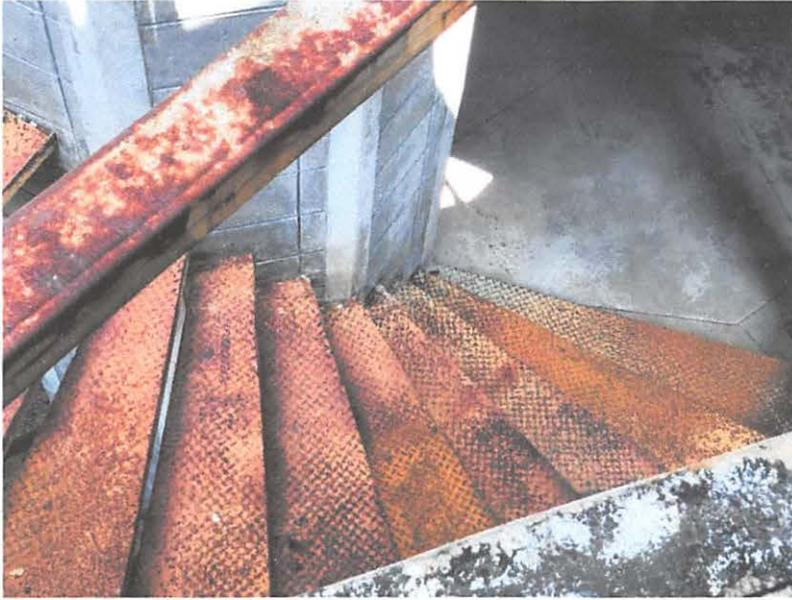
Se observa el deterioro por oxidación en las escaleras de la torre de control.
