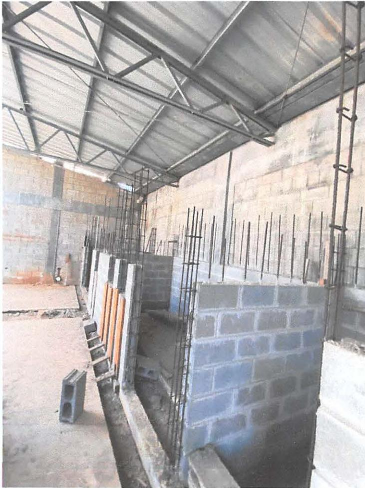
Se observa construcción de paredes internas de bloques de hormigón con acero de refuerzo y de columna de amarre expuestos y con signos de oxidación.
