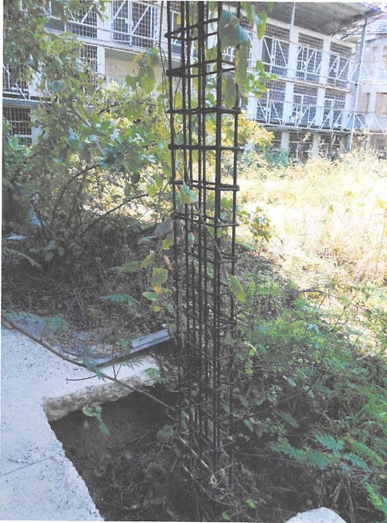
Se observa el acero de refuerzo de columna expuesto que evidencia signos de oxidación.
