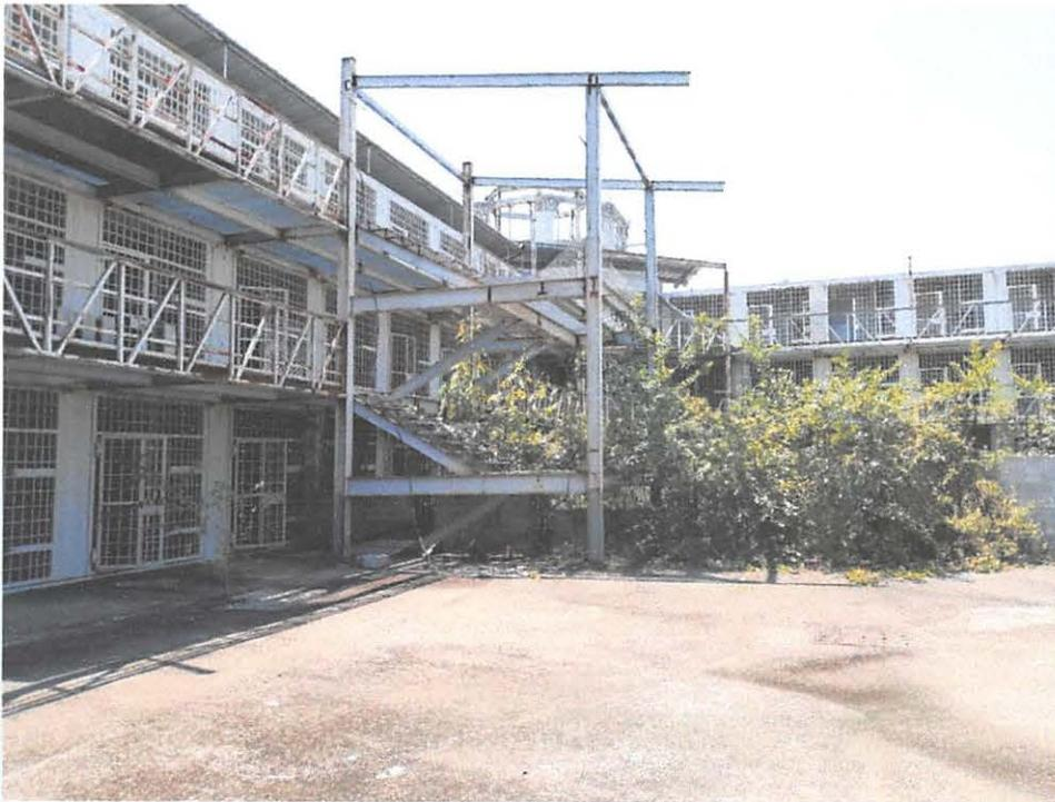
Se observa elementos de acero con signos de oxidación – estructura soporte de la pasarela, barandales, rejas de celdas, barandales y estructura de escalera.
