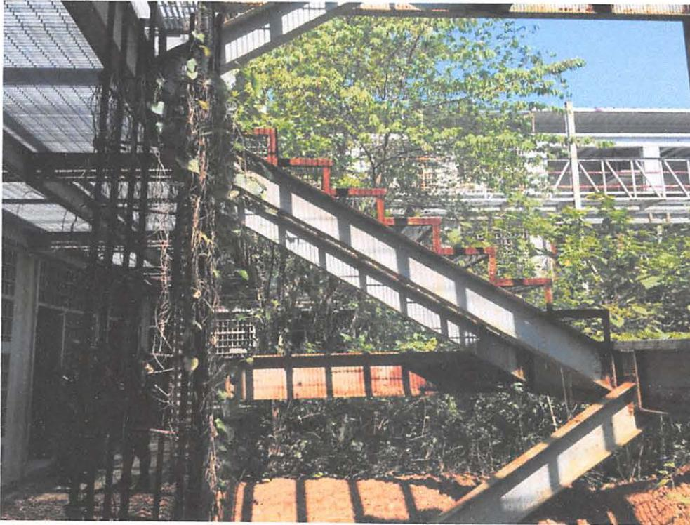
Se observa signos de oxidación en los elementos de acero –estructura de la escalera y acero de refuerzo expuesto.
