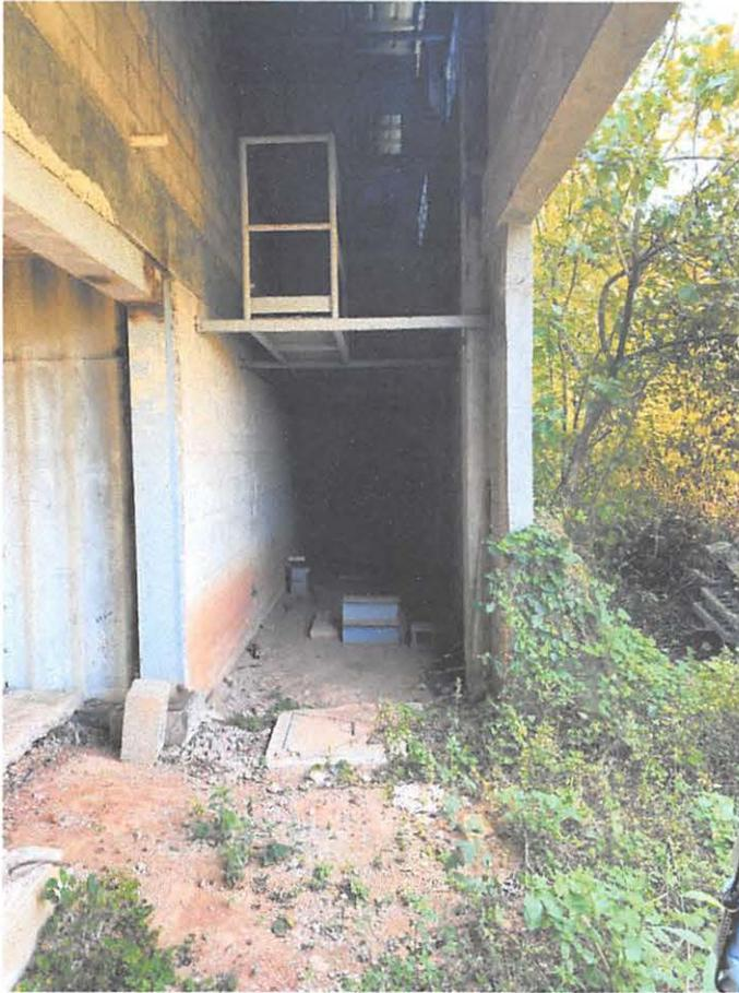
Se observa la construcción del muro interior de bloques de bloques y acero para el pasillo de mantenimiento, las cámaras de inspección de y las estructuras de soportes aéreas para los sistemas electromecánicos.
