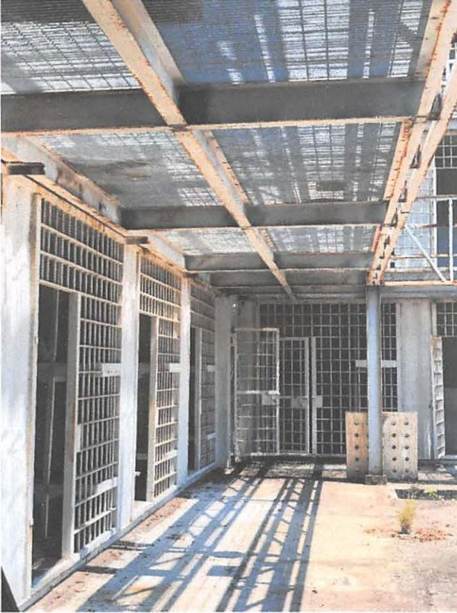
Se observa signo de oxidación en la estructura de soporte de la pasarela. El emparrillado del piso de la pasarela no muestra signo de deterioro por oxidación.
