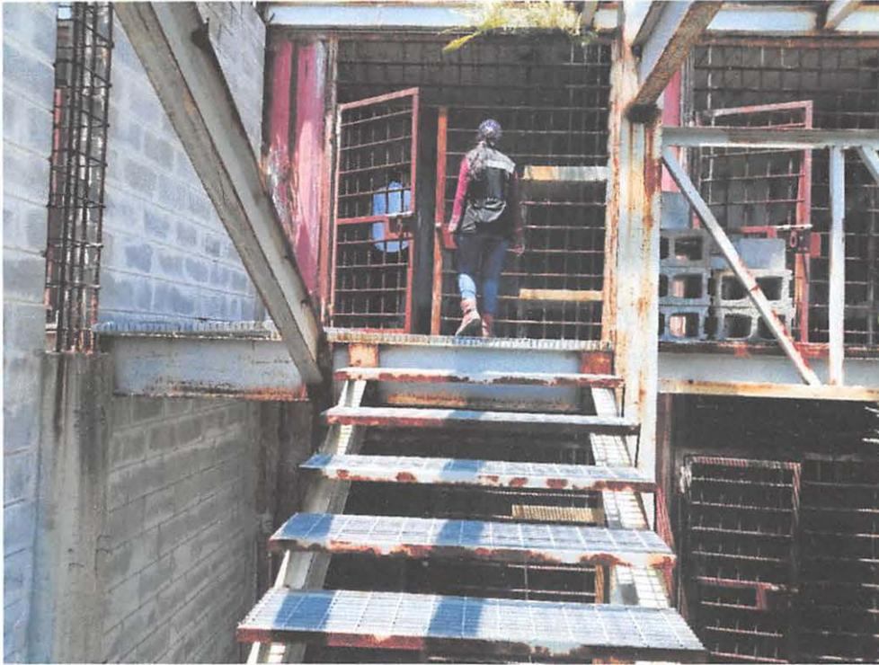
Se observa elementos de acero con signos de oxidación – escaleras, rejas de celdas, estructura soporte de la pasarela, refuerzo de columna.
