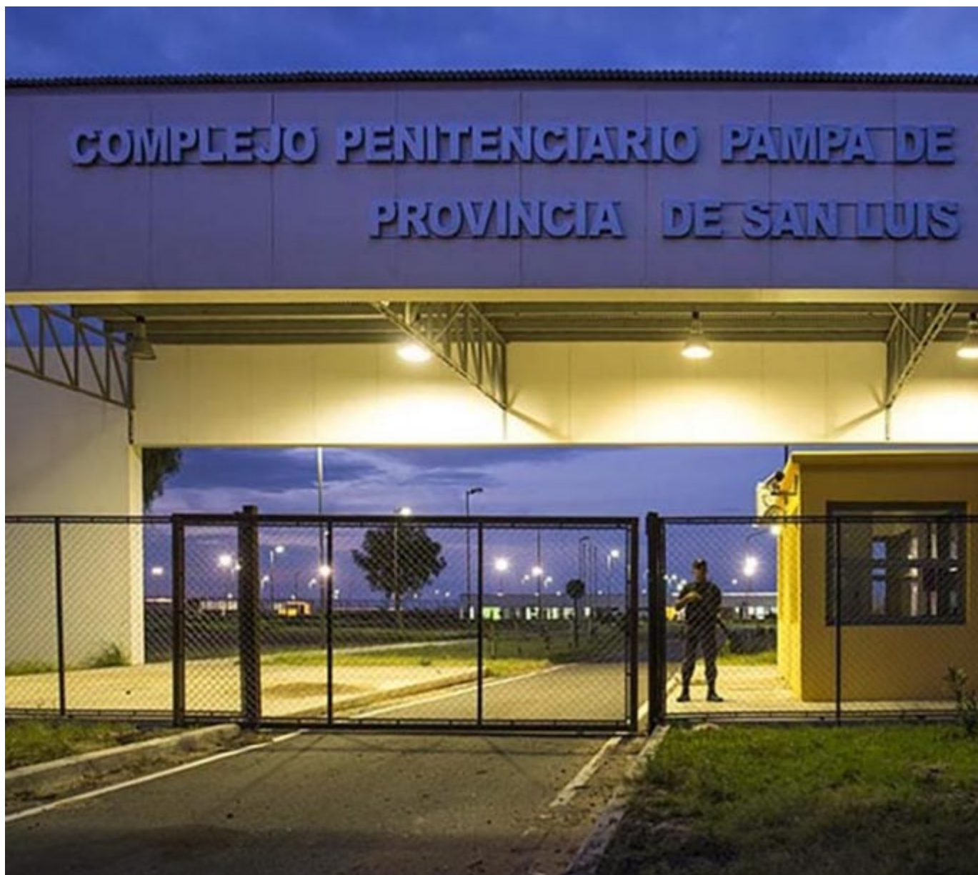
Complejo Penitenciario de Máxima Seguridad "Pampa de las Salinas".
